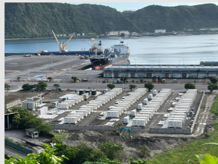
宜蘭50MW儲能案場(建置中)
