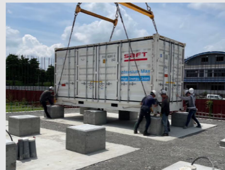
高雄4MW儲能案場(建置中)
